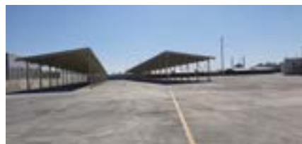
Neubau der Grenzkontrollstelle in Kapikule mit Schattendächern für über 100 LKW und Ablademöglichkeiten im Hintergrund.
